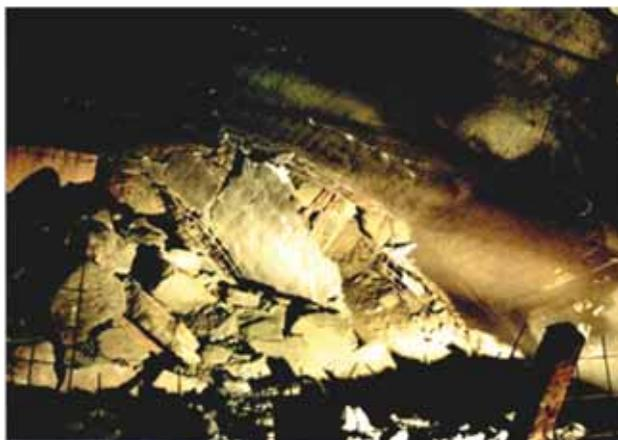
*Obr. 14 Vnitřní rozval v kalotě tunelu po havárii portálu*
