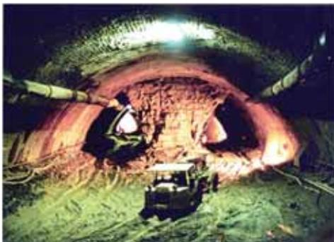
**Obr. 2 Opěrové štoly a ražba kaloty v oblasti východního portálu**
