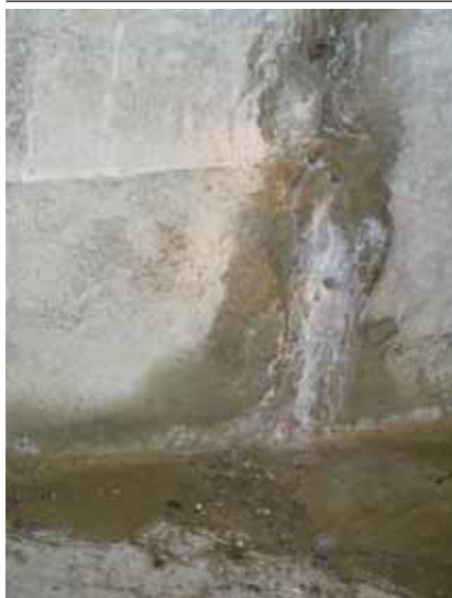
Obr. 17. Bílé zbarvení povrchu obvodové betonové stěny rozpuštěnými solemi v průchozím VZT kanálu
