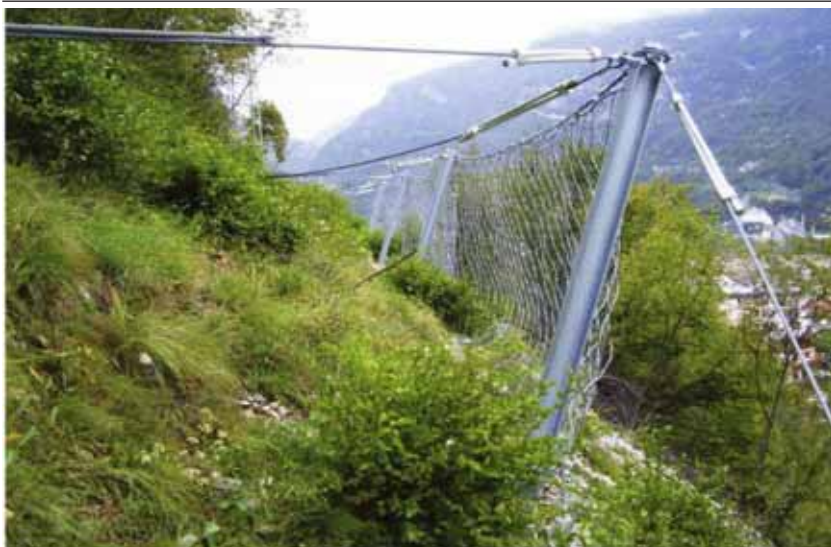
Obr. 10 Dynamická bariéra s podélnými tlumiči energie
