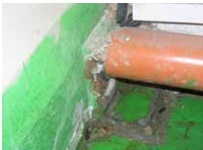
Obr. 5. Prosakování vody na podlahu garáže v místě prostupu kanalizačního potrubí rampy u vjezdu do garáží
