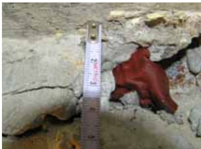
Obr. 21. Pravděpodobně zbytky těsnících bentonitových pásků pod stropem dutinách stěn
