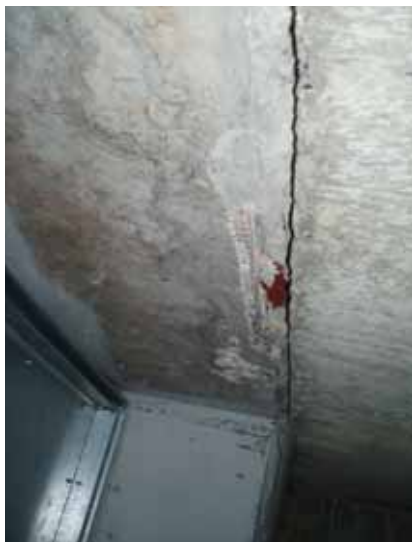
Obr. 14. Lineární průběh trhliny na styku suterénní železobetonové konstrukce s odvětrávacím vzduchotechnickým kanálem
