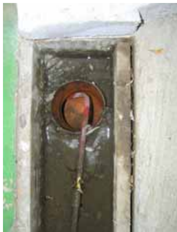
Obr. 2. Odvodňovací žlábek s koncovým výtokovým potrubím
