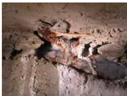
Obr. 20. Pravděpodobně zbytky těsnících bentonitových pásků pod stropem v dutinách stěn
