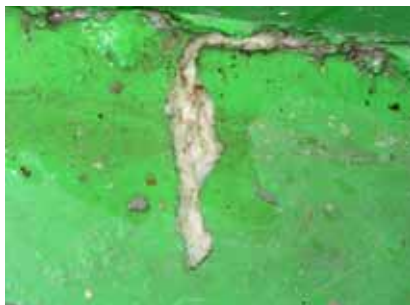
Obr. 6. Pravděpodobné utěsnění spáry mezi rampou a podlahou silikonovým tmelem
