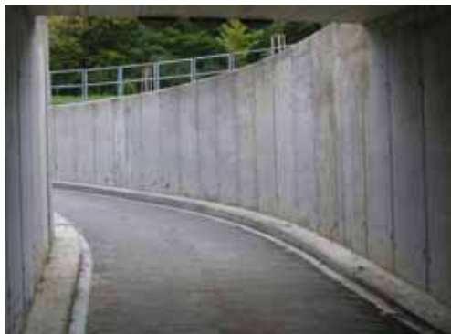
Obr. 1. Poměrně velký spád rampy cca 8° směrem ke garáži
