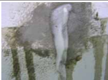
Obr. 10. Detail ze zainjektovaného otvoru v obvodové stěně na západní straně
