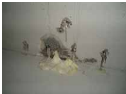
Obr. 26. Nezdařilé utěšňování prosakujících míst nad podlahou
