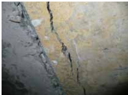
Obr. 16. Zakřivené trhliny v okolí místa styku VZT kanálu s obvodovou
