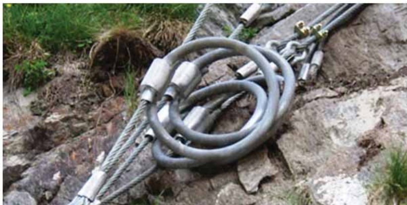
Obr. 9 Detaily konstrukčních částí dynamické bariéry
