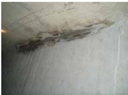
Obr. 25. Utěšňování prosakujících míst pod stropem bez úspěchu
