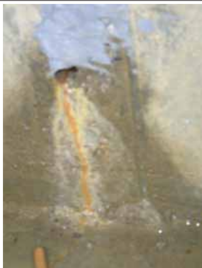
Obr. 18. Vytékání prosakující vody z obvodové betonové stěny v průchozím VZT kanálu
