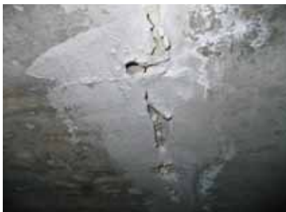
Obr. 23. Utěšňování spáry mezi VZT kanálem a suterénní stěnou bez úspěchu
