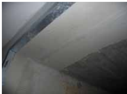
Obr. 24. Oprava trhliny mezi lemuující stěnou a kanálem lepicím tmelem a perlínkou Pravděpodobně zbytky těsnících bentonitových pásků pod stropem v dutinách stěn
