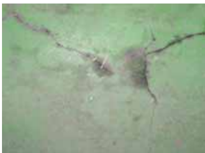
Obr. 7. Trhliny na povrchu rampy u vjezdu do garáží ve 2.PP
