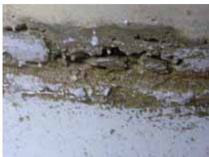
Obr. 19. Degradace betonu v místě přechodu stěny ke dnu vzduchotechnického kanálu
