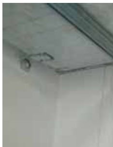
Obr. 11. Svislé proužky po vytékající vodě z VZT potrubí na vnitřní nosné stěně
