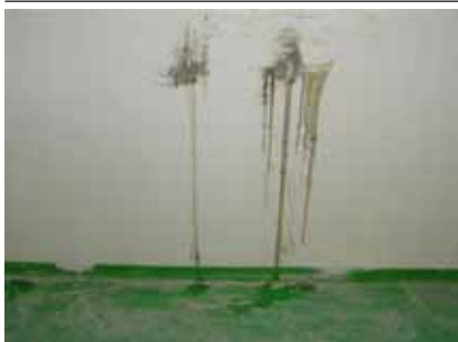
Obr. 9. Výrazně zbarvená místa po vytékající vodě ze stěn na západní straně
