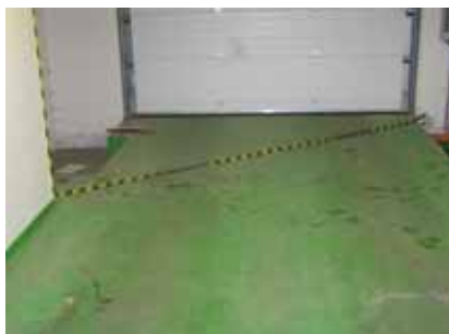
Obr. 3. Dodatečně osazená zářezka napříč vyrovnávací vnitřní rampy směrem ke sběrné jínce
