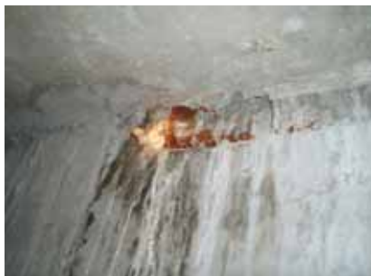
Obr. 15. Průsak podzemní vody do VZT kanálu
