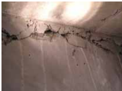
Obr. 22. Dutiny v místě napojení stropu k obvodové stěně Pravděpodobně zbytky těsnících bentonitových pásků pod stropem v dutinách stěn
