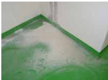
Obr. 12. Světlé povlaky soli po odpaření vodě na podlaze garáží východnítrane
