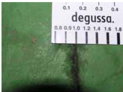
Obr. 8. Šířka trhliny cca 1 mm na povrchu rampy u vjezdu do garáží ve 2.PP
