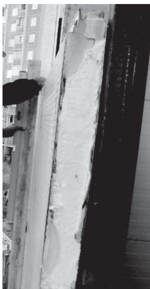
Рис. 3. Измерение недопустимого отклонения панелей от вертикали
