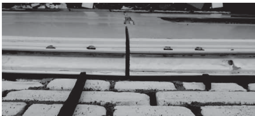
Рис. 5. Узел жесткого крепления стеновых «Сэндвич»-панелей
