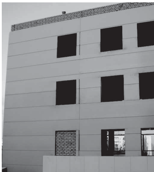
Рис. 4. Ошибочная рассечка вертикальных швов
